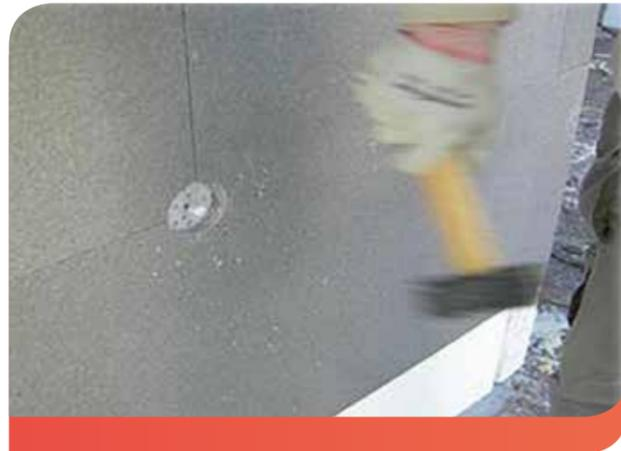
schema di tassellatura specifico per la tipologia di materiale isolante (il numero dei tasselli varia da un minimo di 6 ad un massimo di 14 al m<sup>2</sup>, in funzione dell'esposizione al vento e dell'altezza dell'edificio), seguire le indicazioni del manuale Cortexa. L'operazione di fresatura può essere eseguita solo con materiale isolante in EPS e lana minerale (WOOL) con spessore uguale o superiore a 8 cm;
