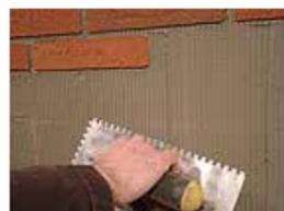
1. Applicare l'adesivo con una spatola dentata da 4mm su una superficie di max 1m<sup>2</sup> per volta.
