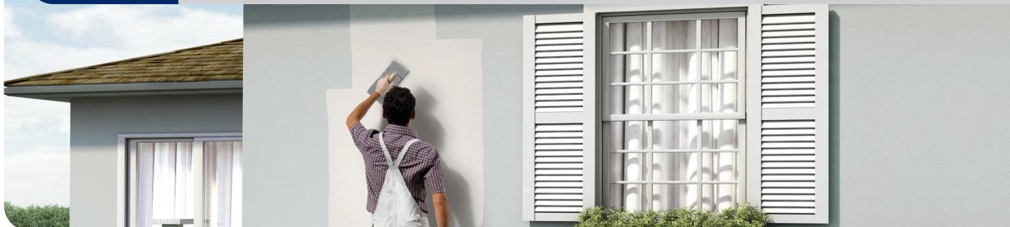
**CORAL MASSA ACRÍLICA** tem alto poder de enchimento, ótima aderência, é fácil de lixar e aplicar. Indicada para uniformizar, nivelar e corrigir pequenas imperfeições em superfícies externas e internas de alvenaria e concreto.
